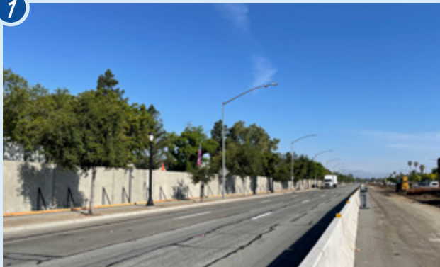
Capitol Expressway được mở rộng ở các khu vực để có chỗ trong dải phân cách. Không gian này là cần thiết để tạo điều kiện cho sự di chuyển của các thiết bị nặng sẽ được sử dụng để tạo nền tảng.
