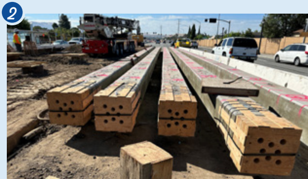
2 Ang mga pile ay ibinaon sa 80 talampakang lalim. Ang mga pile na ito ay susuporta sa mga haligi.
