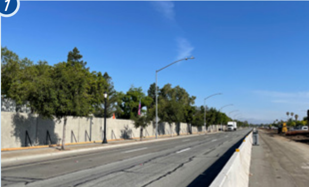
Se ensancha Capitol Expressway en algunas zonas para crear espacio en el camellón. Facilitando así el movimiento de equipo pesado que se utilizará para construir los cimientos.
