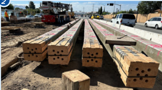
Cọc được khoan đến độ sâu 80 feet. Những cọc này sẽ hỗ trợ các cột.
